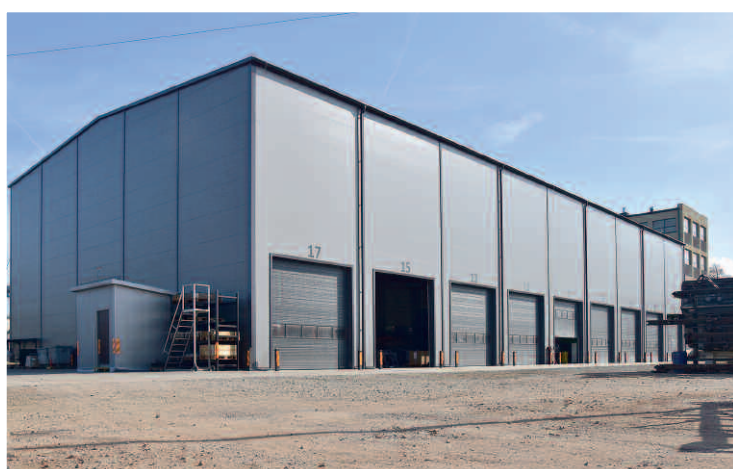
W 2019 r. na terenie siedziby firmy stanęła nowa hala montażu końcowego
